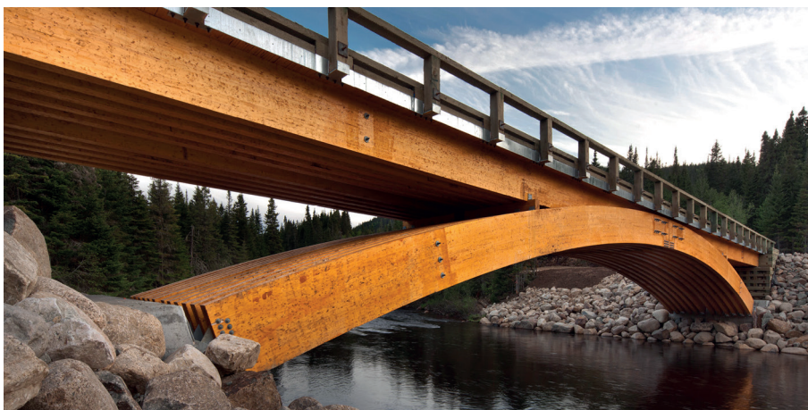
Figura 7: Puente de madera
